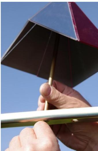
Nehmen sie nun die Zahnscheiben und die Flügelmutter und schrauben diese auf das Gewinde auf. Ziehen sie die Flügelmutter gut fest.
